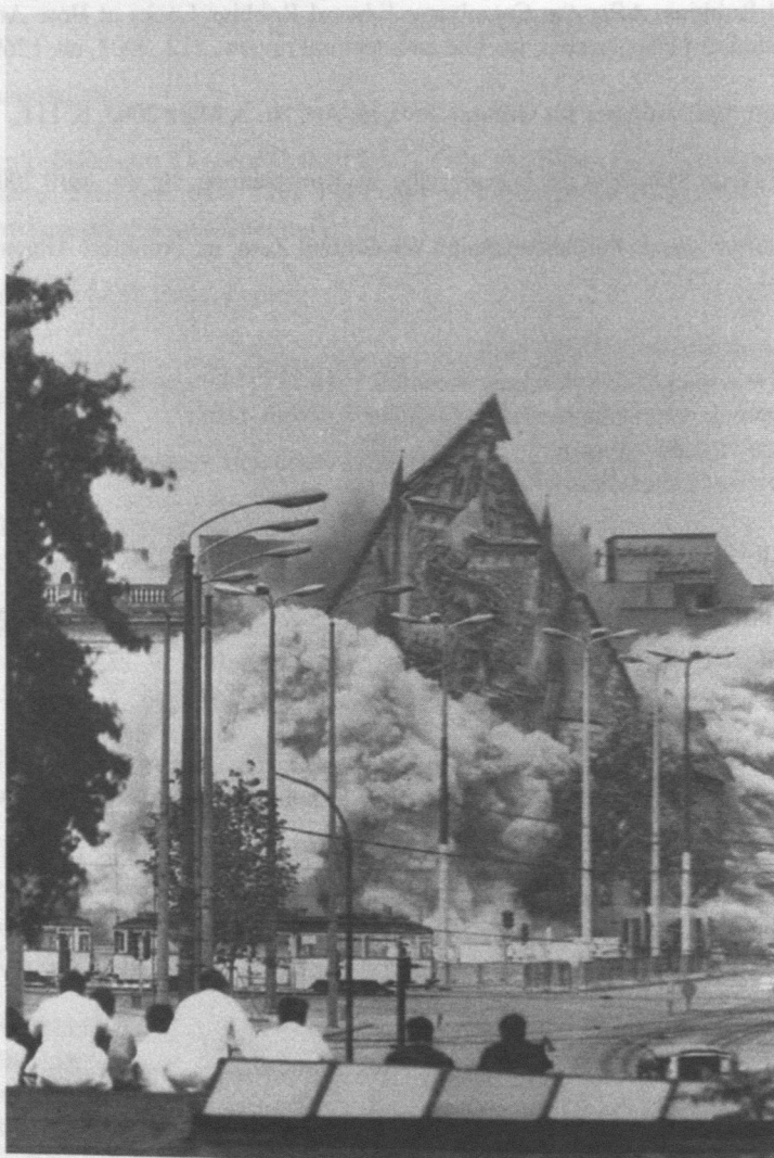
Abb. 1: Sprengung der Universitätskirche St. Pauli, 30. Mai 1968 (Aufnahme von Osten)
