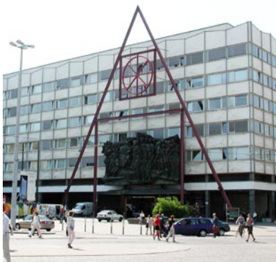
Hauptgebäude mit Installation Paulinerkirche um 2000
